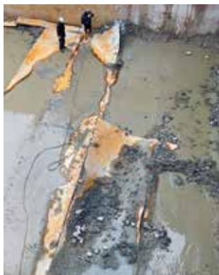
Øverste del af "dobbelt bunden" i Grane-R skal skiftes.
